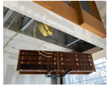
Einbau der Windlade
